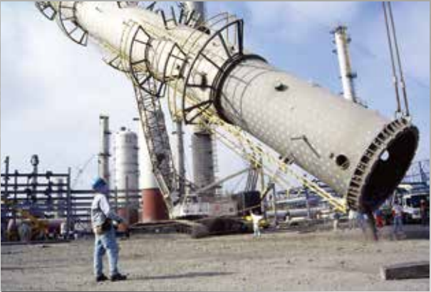
廠房與塔槽安裝
